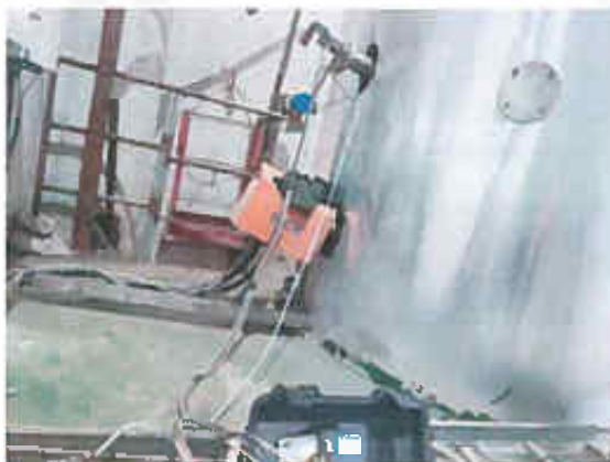
1#排气管 DA001 (Q1) 有组织排放废气
